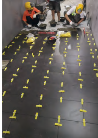
瓷磚鋪設工程
