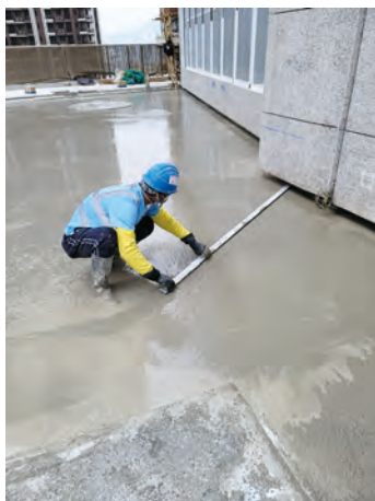
鋪設地台工程
